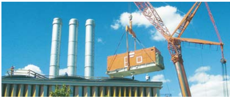
Установка агрегата на крыше здания, расположенного в центре города Вюрцбурга, Германия.
